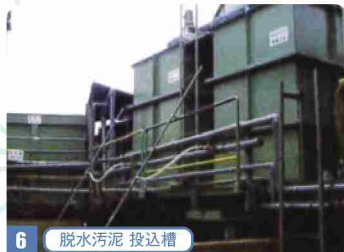
6 脱水汚泥 投込槽
